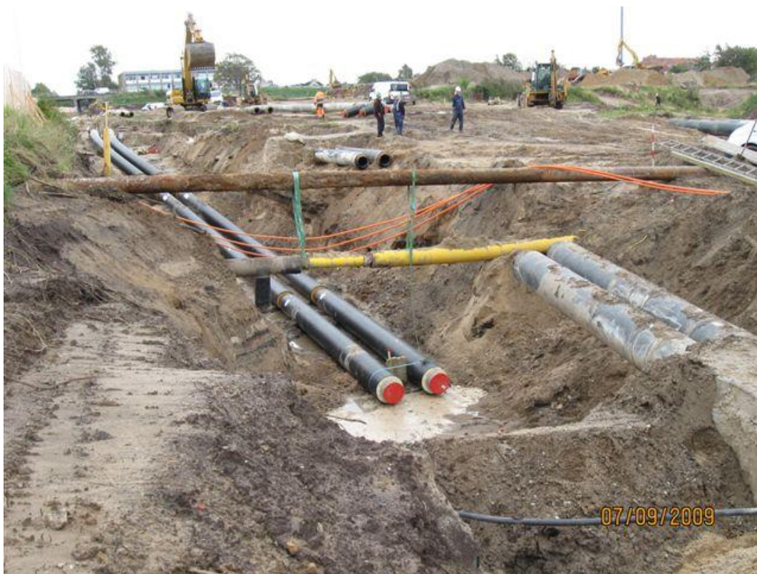
Omlægning af ledningsnet på Bispetervet
