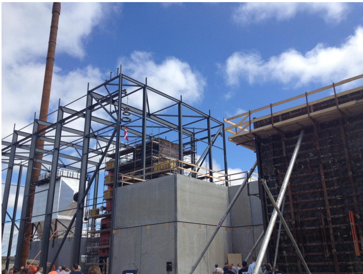
Rejsegilde på biomasseanlægget 31. maj 2013
