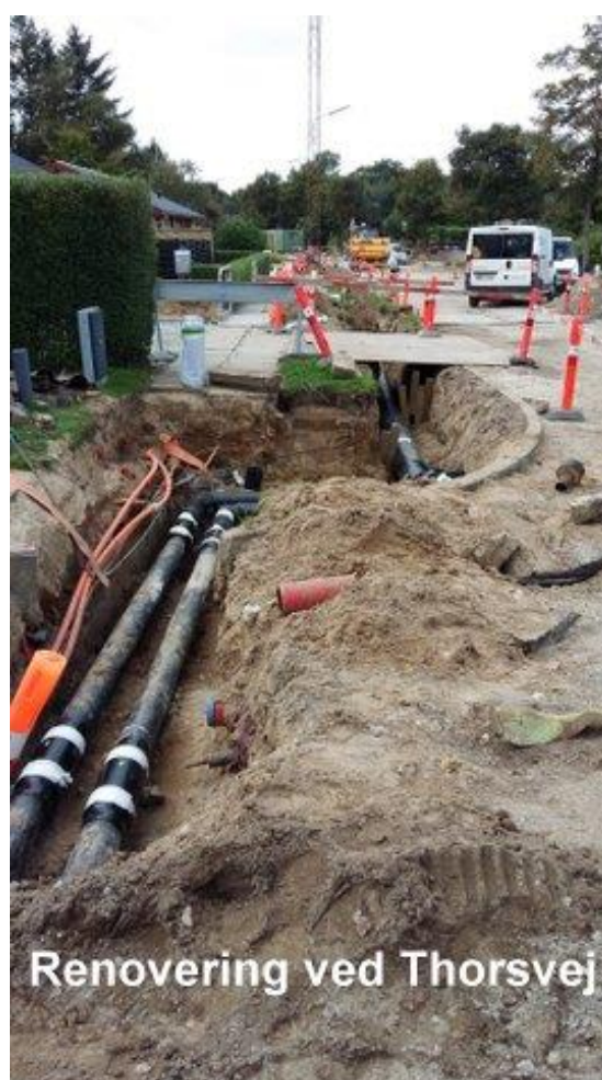
Renoveringsarbejder på distributionsnettet
