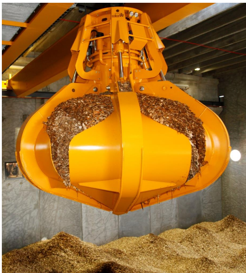
Kranen på biomasseanlægget
