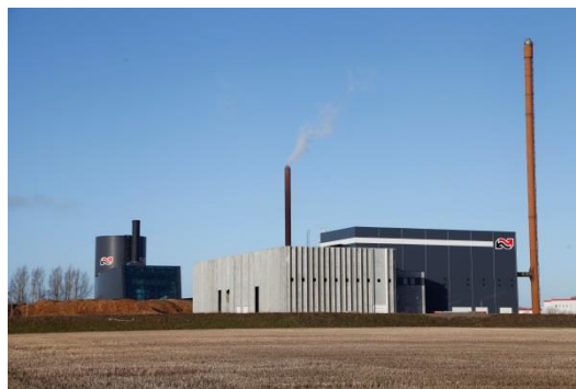
Biomasseanlægget med kraftvarmeanlægget i baggrunden
