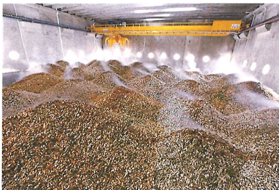
Indendørs flislager Biomasseanlægget
